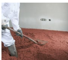
Die Anschlusskanten an der Mauer nacharbeiten und aufgetragene Fläche verdichten.
